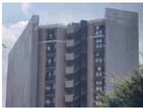
2020年8月 東京都 ザ・パークハウス 三鷹レジデンス 外壁一部 施工面積：100㎡
