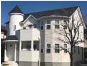
2021年2月 埼玉県 一般住宅 外壁 施工面積：400㎡
