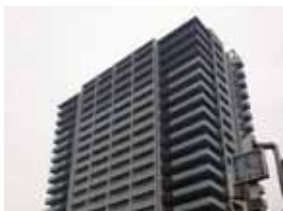
2018年5月 愛知県 エムズシティ知立 ザ・タワー 外壁 施工面積：4,000㎡
