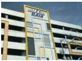
2018年9月 広島県 メガガイヤ福山明神店 外壁 施工面積：2,300㎡
