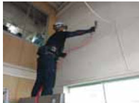
2020年9月 奈良県 障害者作業施設 内装 施工面積：250㎡
