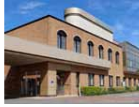
2022年1月 北海道 豊浦町国保病院 内装 施工面積：754㎡
